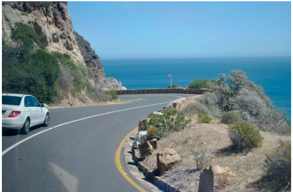
Гірська дорога поблизу Кейптауну
