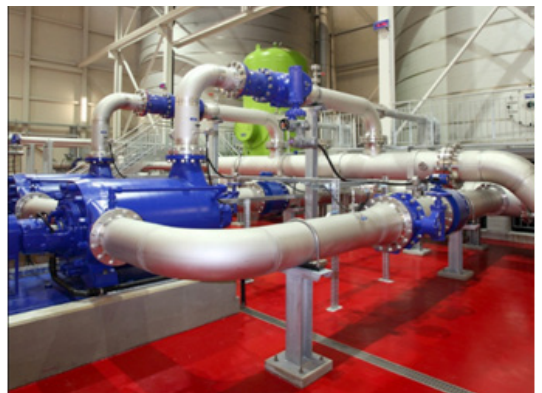
Насосна станція високого тиску після реконструкції 2010 р.
