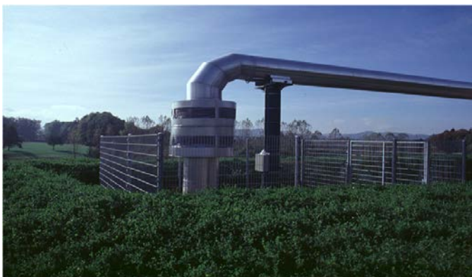
Магістральний водогін після реконструкції 2010 р.
